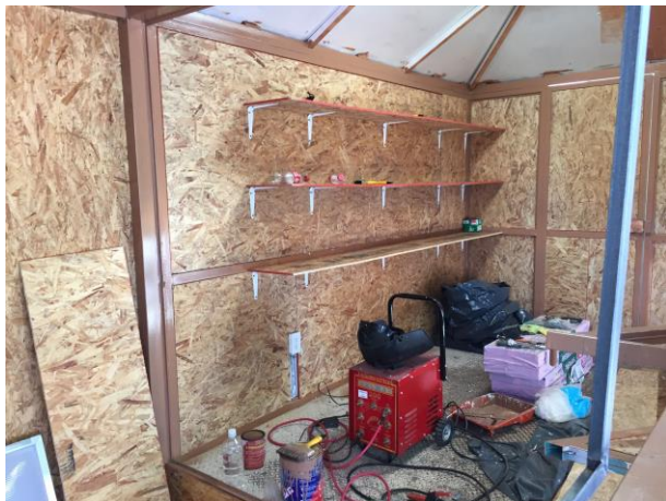
Imagen I. Avances de la construcción del local de la comercializadora dentro del ITJ.
