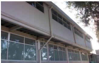
IMG 6.) SISTEMA DE CAPTACION DE AGUA PLUVIAL.
